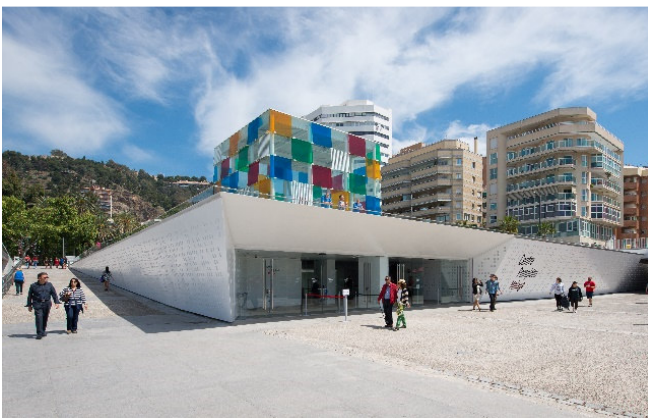
Centre Pompidou Málaga CCBYSA Epizentrum-at-Wikimedia.Commens
